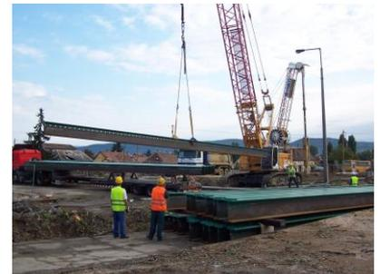
Auf den Fotos sehen wir die Hauptstahlträger der Eisenbahnbrücken in Pilisvörösvár und Óbuda, welche durch eine von unserer Gesellschaft durchgeführte TSA Aluminium Metallspritzung mit einer Korrosionsschutzbeschichtung unter Anwendung der englischen Metallisation Ltd. Anlage versehen wurden.
