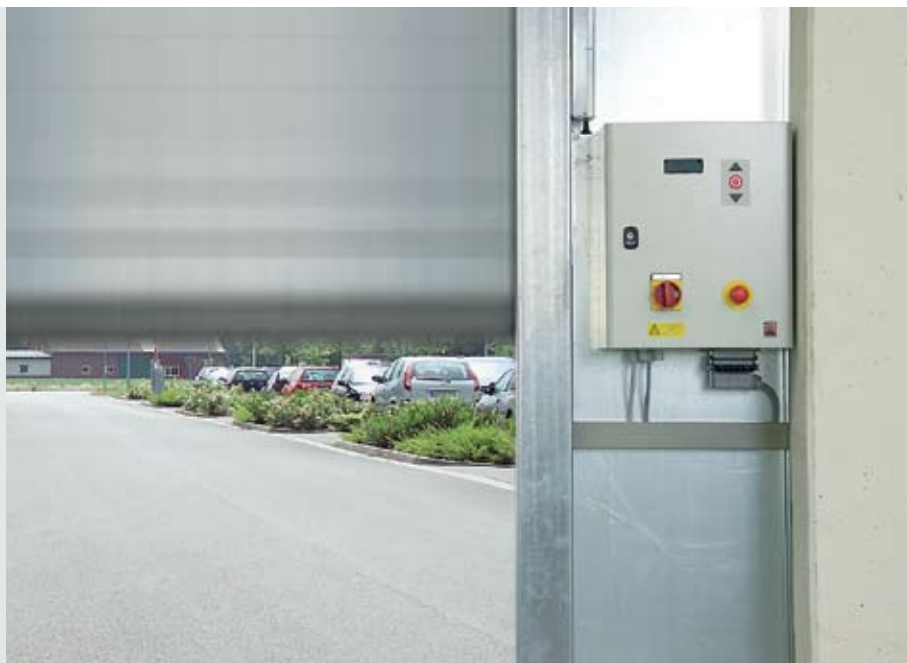
A spirálkapu a Hörmann FU-vezérlés által éri el a nagy sebességet
